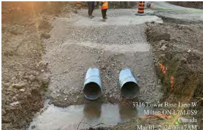
**2.1.3 Lower Base Line – Excavation et pose de ponceaux de 600 mm**
